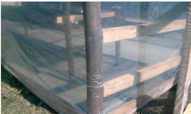
**Figura 20.** Detalle de sujeción del polietileno a la estructura de madera.
