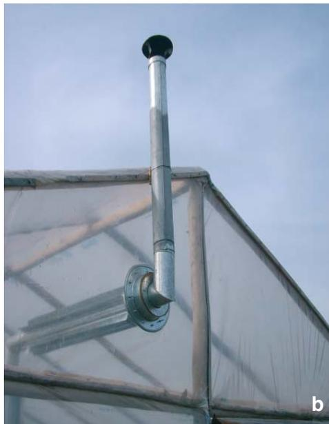
**Figura 16.** (a) Salida de la chimenea a través del polietileno. (b) Vista del sistema de aislación.
