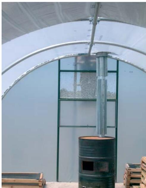
**Figura 8.** Vista de estufa con chimenea aletada con salida por el techo de polietileno.
