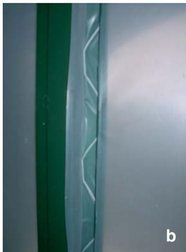
**Figura 19 a y b.** Fijación del polietileno mediante baguetas metálicas.
