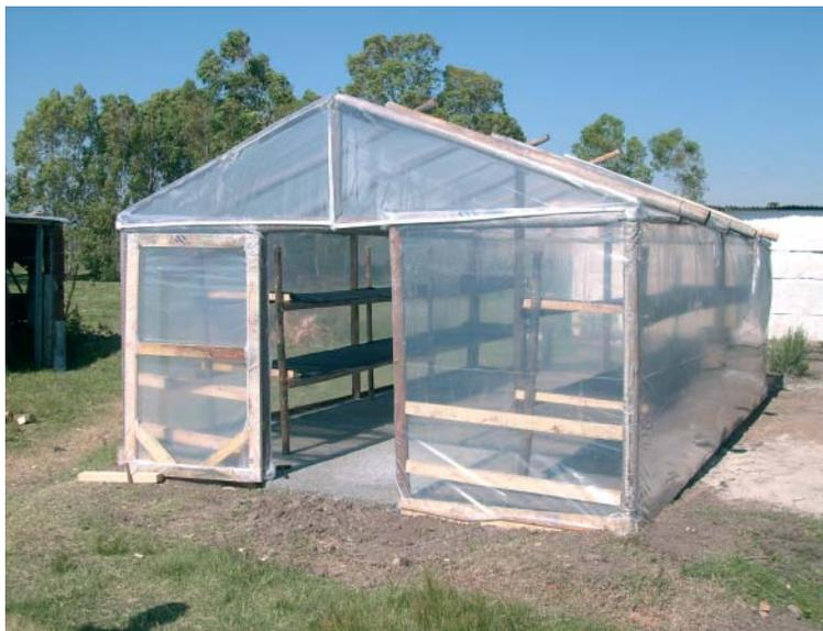
**Figura 11.** Secadero tipo invernadero con ventilación transversal.
